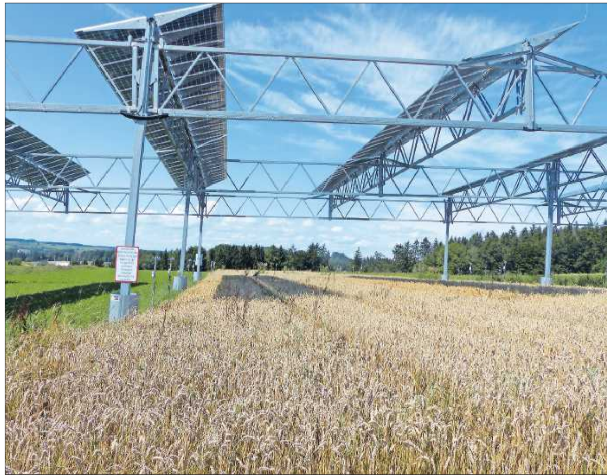
Die Solarmodule stehen fünf Meter über dem Acker. Sie erzeugen nicht nur Strom, sondern werfen auch Schatten, was in den Sommermonaten die Pflanzen vor übermäßiger Sonneneinstrahlung schützt. FOTO: SÜDPFALZ-ENERGIE
